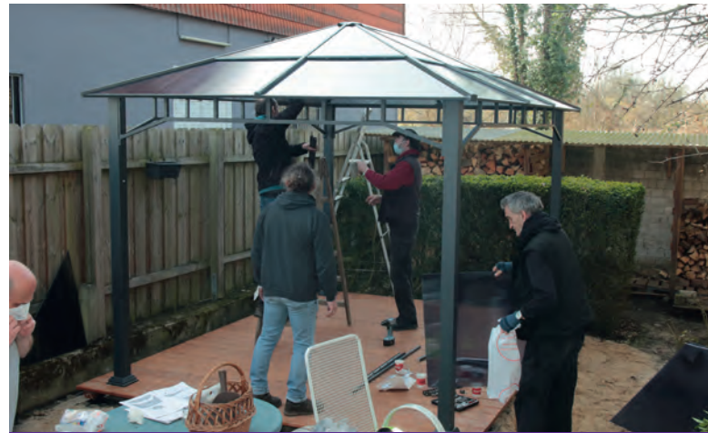
Der Pavillon an der Tageswohnung wird aufgestellt.
